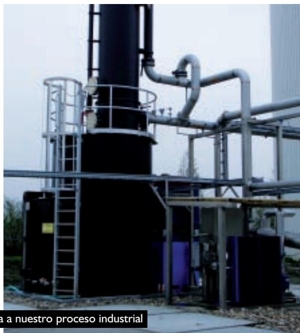
La lavadora de biogás facilita la incorporación de esta fuente de energía a nuestro proceso industrial
