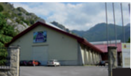
Instalaciones de Agua de Cuevas en Felechosa.
