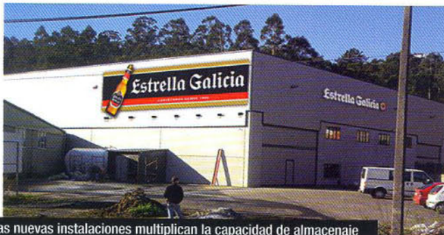
Las nuevas instalaciones multiplican la capacidad de almacenaje
