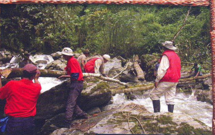
Construyendo un puente en Pintobamba
